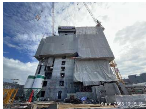
รูปที่ 59 ติดตั้งผ้าใบก่อสร้าง (Mesh Sheet) คลุมตลอดความสูงของตัวอาคารโครงการ
