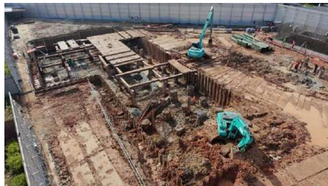
รูปที่ 51 ติดตั้งแผงเหล็กพืด Sheet Pile และระบบค้ำยัน งานระบบชั้นใต้ดิน
